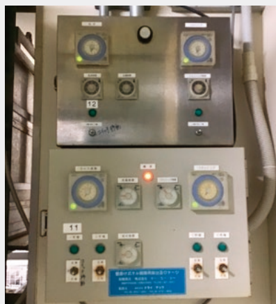
写真5：トレーを稼働させるための設定パネル。
