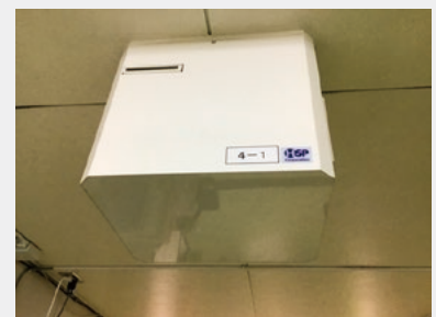
写真3：超音波自動噴霧装置、左上の平たい口からスーパー次亜水が超音波噴霧される。
