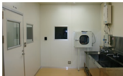
写真5 準備室と前室入口およびパスボックス
