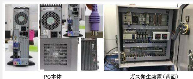
図9 複合ガス除染した電子機器類 ※腐食や劣化は観察されなかった
