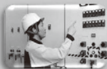
設備運転保守業務
