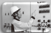
設備運転保守業務
